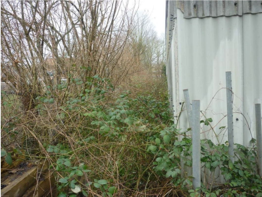
Abbildung 2-4: Blick auf den Übergangsbereich zwischen Scheuch-Areal und KiTa-Grundstück im Süden. Rechts ist die südliche Längsseite der Abstellhalle zu sehen.
