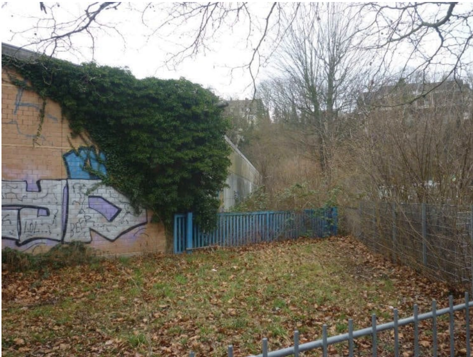
Abbildung 2-11: Südlicher Abschluss der Abstellhalle mit Blick auf den schmalen Zwischenstreifen, der das Firmengelände Scheuch von dem Areal der Kindertagesstätte trennt
