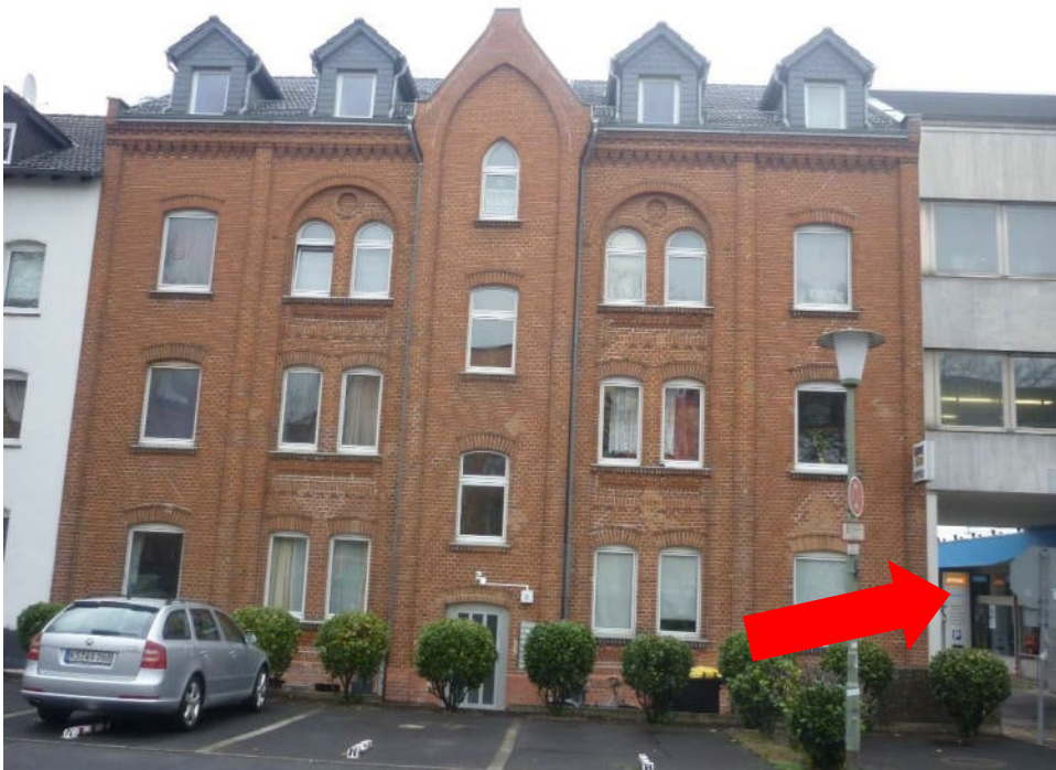
Abbildung 2-13: Blick auf die Häuserfront der Fiedlerstraße 2. Dabei handelt es sich um das direkt an das Verwaltungsgebäude anschließende Wohnhaus. Der rote Pfeil markiert die Zufahrt zum Firmengelände der Fa. Scheuch
