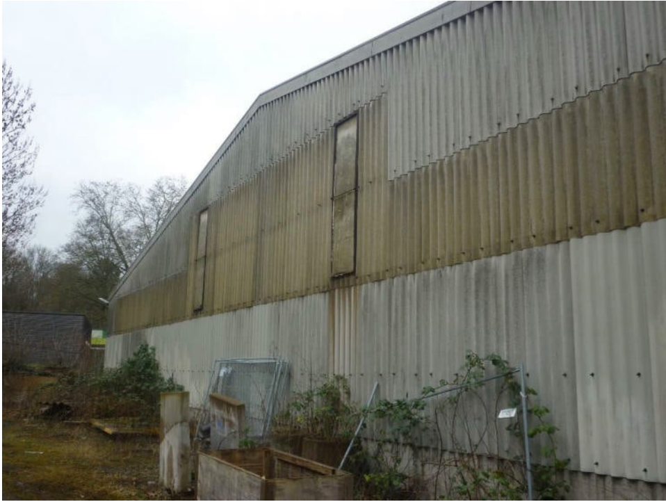
Abbildung 2-2: Rückseite der großen Abstellhalle auf dem Firmengelände
