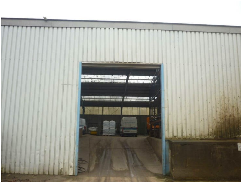
Abbildung 2-6: Einfahrt in die große Lagerhalle auf der Hallenrückseite
