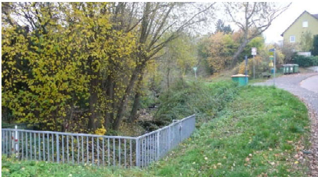
Zugang zum Pangesgraben mit dem Nordshäuser Mühlbach
