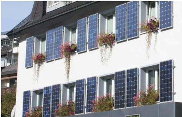
*Photovoltaik an der Fassade
