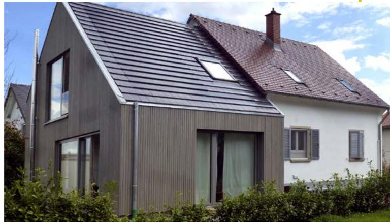
*Photovoltaik als Dachintegration
